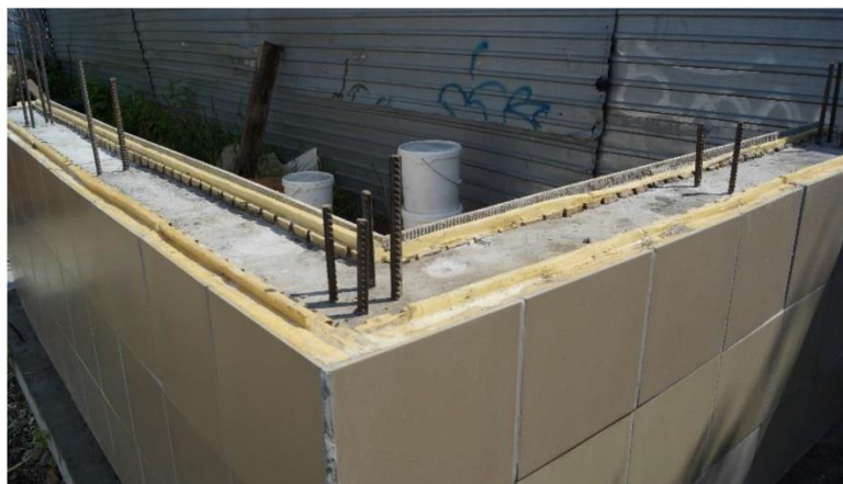
Рис. Образец залитой стены с использованием данной несъёмной опалубки
